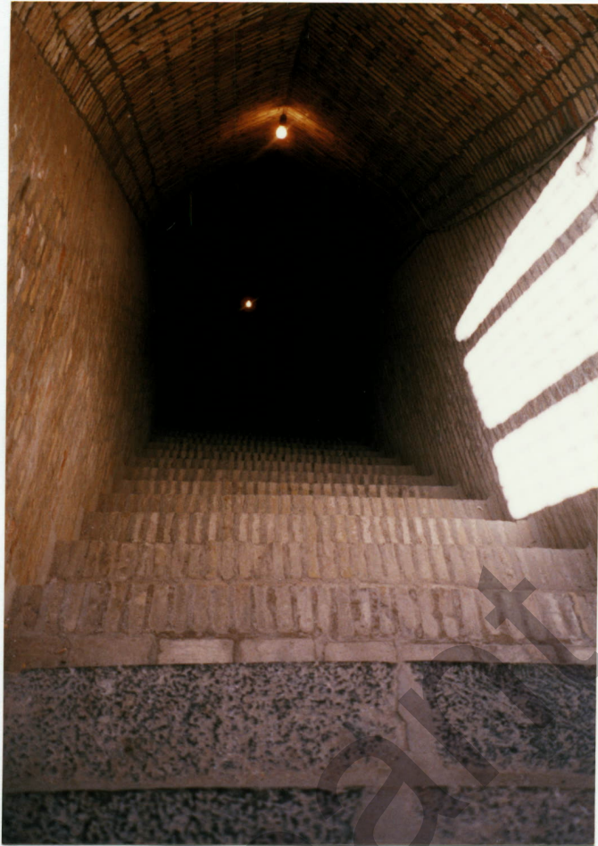
عکس شماره ۷: نمایی از ورودی پایاب مسجد جامع یزد که دارای ۵۴ پله می باشد و آب قنات زارچ در حال حاضر در آن جریان دارد
