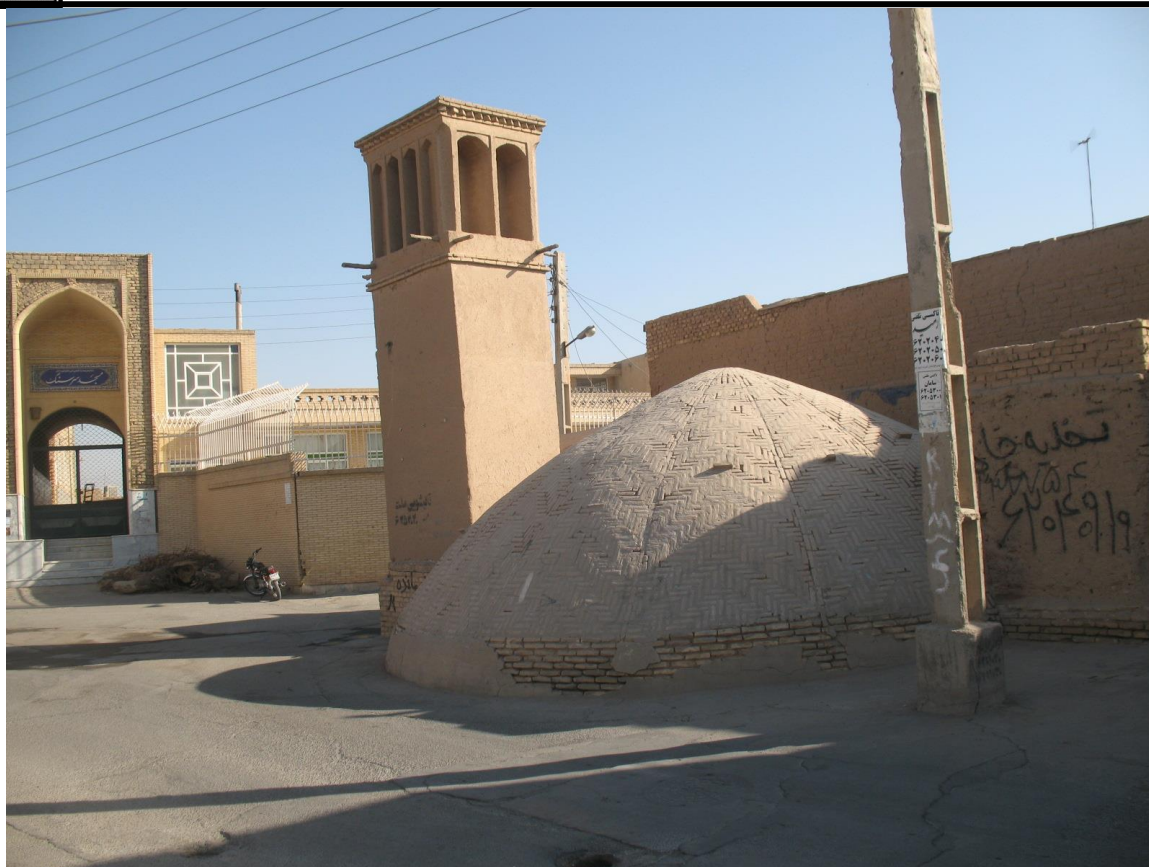
تصویری از آب انبار سرسنگ
