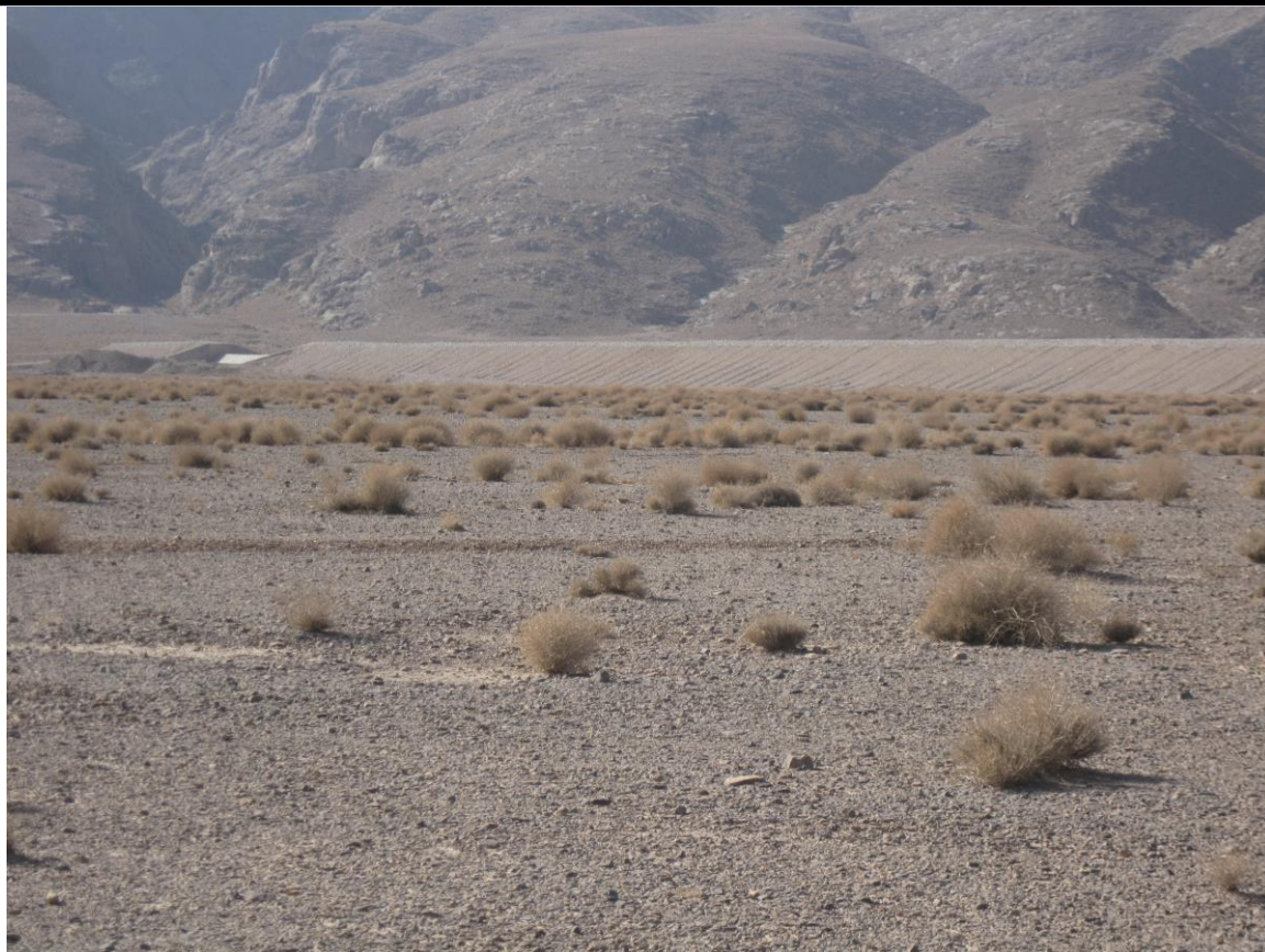
تصویری از بندخاکی که جهت تقویت مادرچاه های قنات حسن آباد احداث گردیده است
