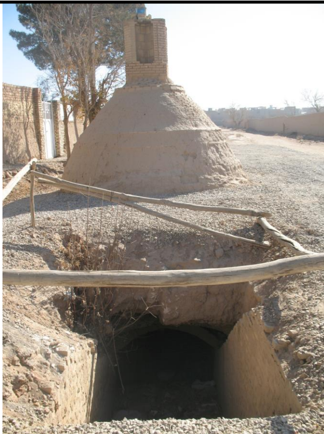
آب انبارشایق ( جنب زمینهای مزروعی حسن آباد)
